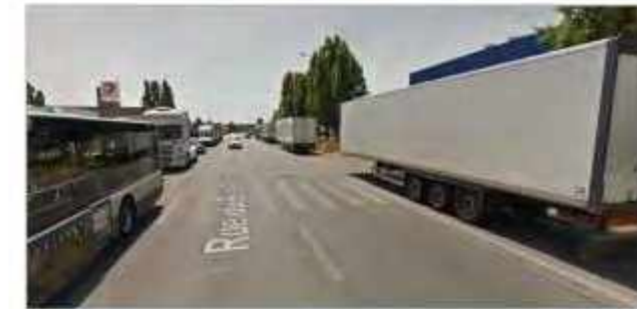
Traversée piétonne Rue du Bas Marin en face de l'hôtel SENIA, sans refuge ni feu tricolore, stationnement PL et remorques fréquents sur le passage
