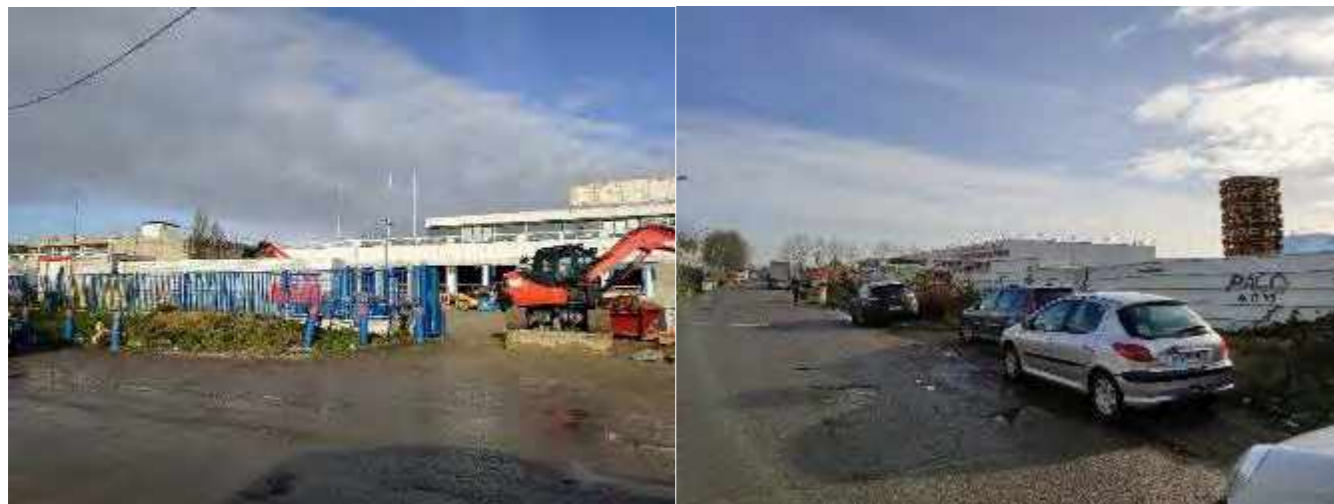
Figure 412 : Illustration de bâtiments destinés à être démolis (rue des Hauts Flouviens, rue du Courson)
