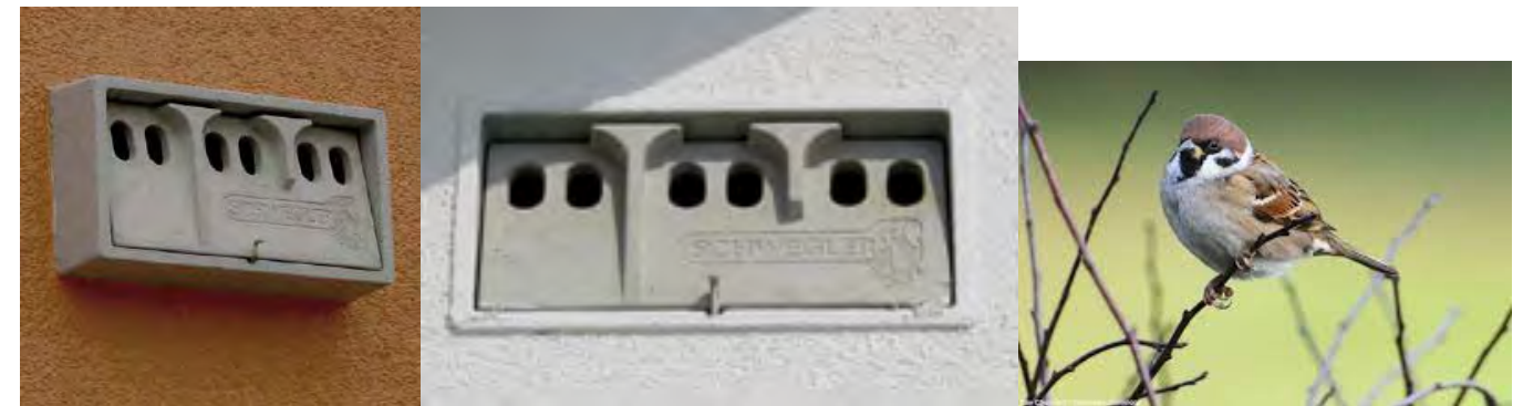
Figure 37 : Nichoir à Moineau (Schwegler) sur la façade (à gauche) ou encastré (à droite)
