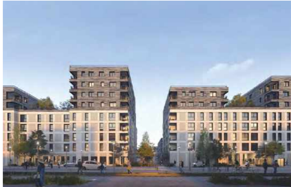
Figure 349 : Vue nord des bâtiments du lot 4.1
