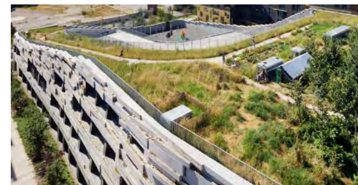
Figure 42 : exemple de toitures végétalisée fonctionnelle (Ecole Boulogne Billancourt-architecte Sophie DERAMOND)
