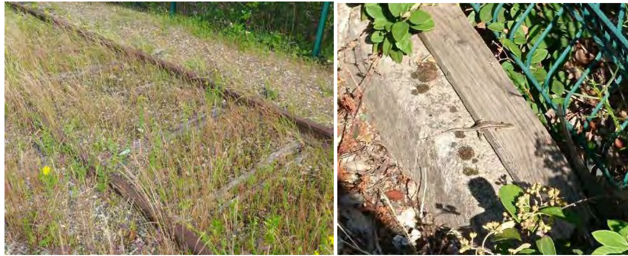
Figure 32 : Fasciés favorable à reconstituer – voie ferrée existante (Confluences)
