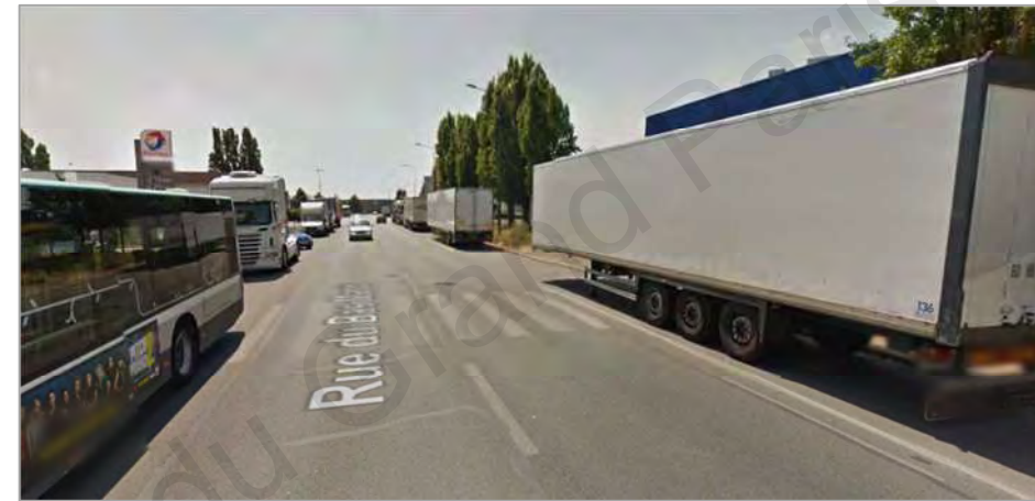
Traversée piétonne Rue du Bas Marin en face de l'hôtel SENIA, sans refuge ni feu tricolore, stationnement PL et remorques fréquents sur le passage
