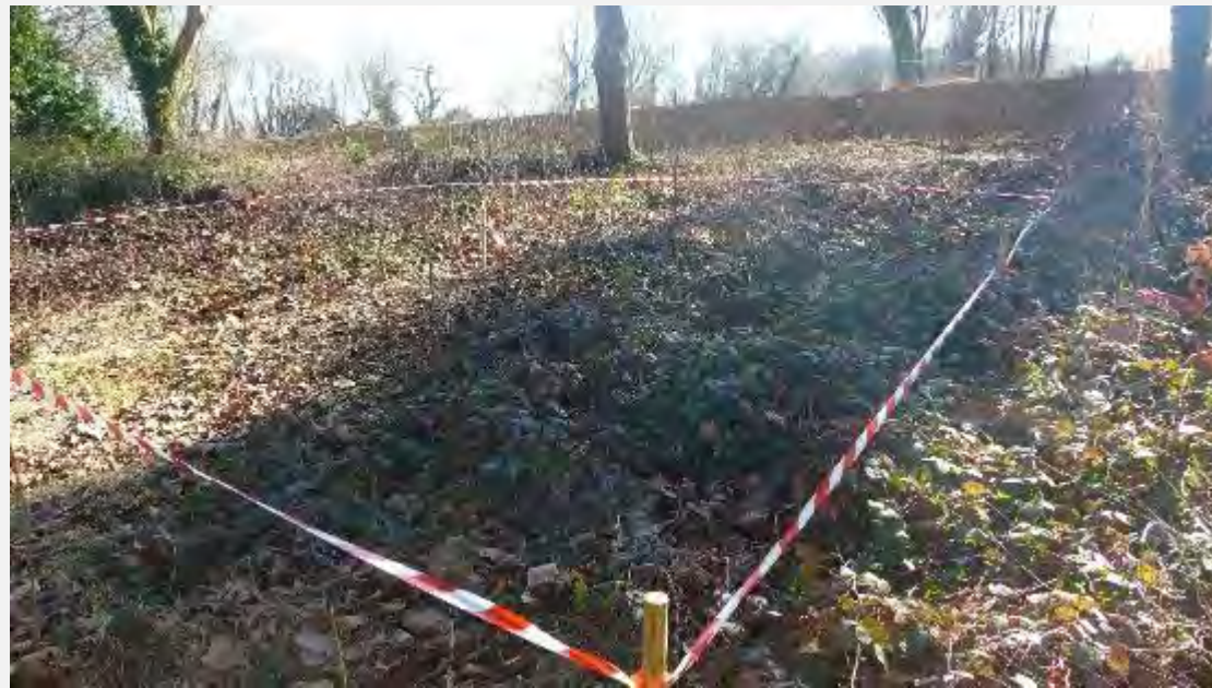
Figure 382 : Exemple de rubalise dans un chantier
