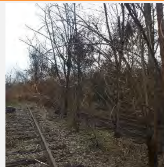
Figure 400 : Fourrée arboré avant restauration
