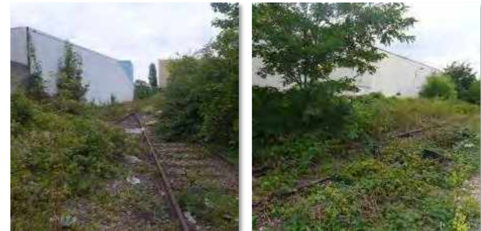
Figure 50 : Anciennes voies ferroviaires désaffectées
