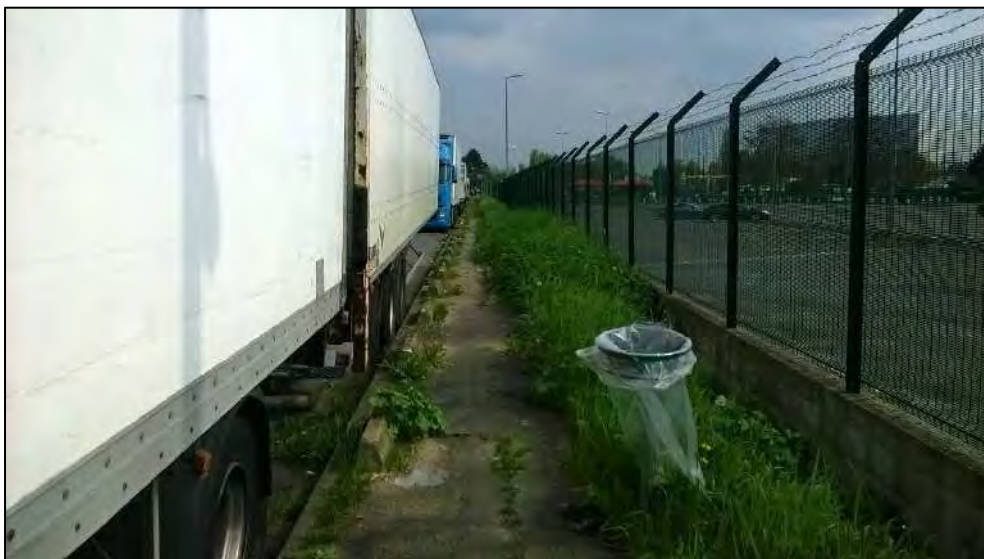
Figure 7 : Trottoir endommagé et envahi par les herbes hautes, rue des 15 Arpents – Source ETC
