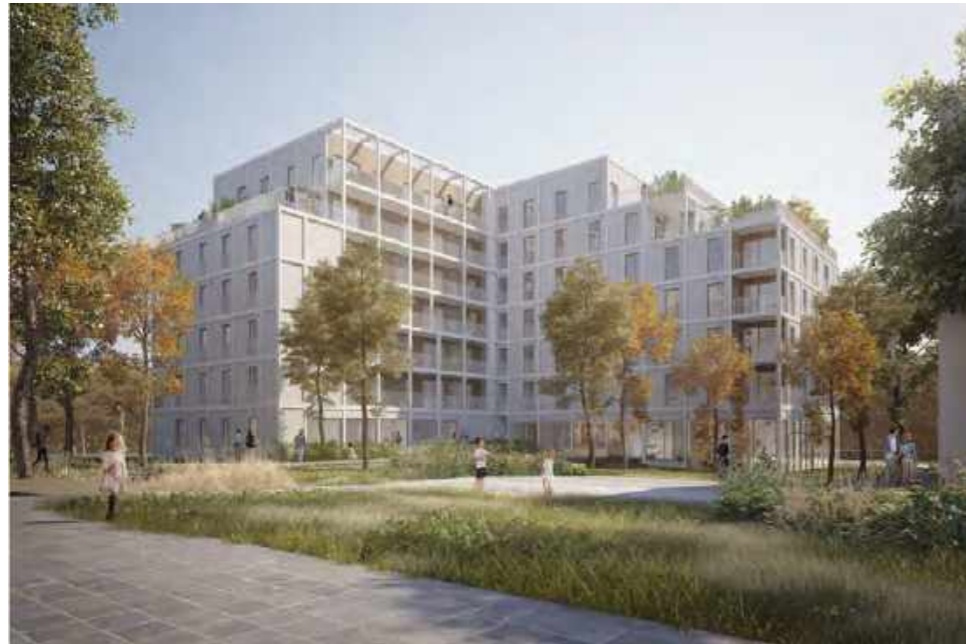
Figure 363 : Vue du cœur d'îlot des bâtiments du lot 4.3
