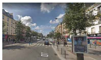
Le Kremlin-Bicêtre – RD7
