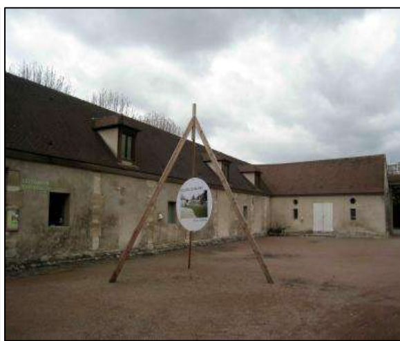
Ferme de Cottinville à Fresnes – Source : petit-patrimoine.fr
