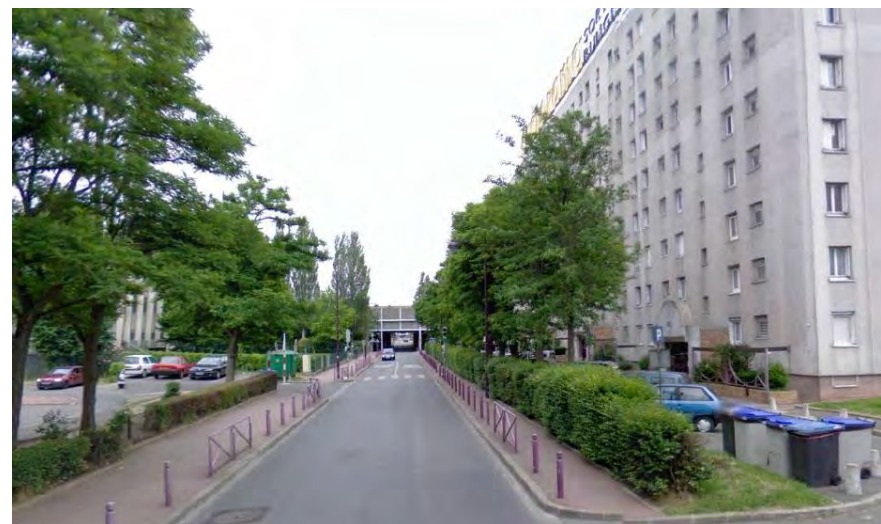
Barrières visuelles constituées par les bâtiments d'habitation et l'autoroute au niveau de la rue Henri Thirard (Source : Etude d'impact, secteur Locarno)
