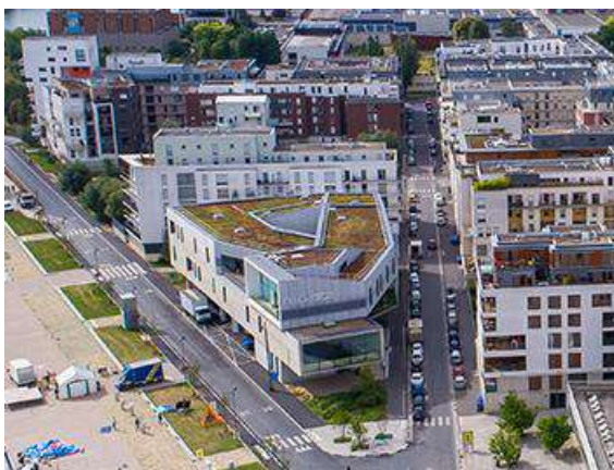
Toiture végétalisée de la Médiathèque Aragon
