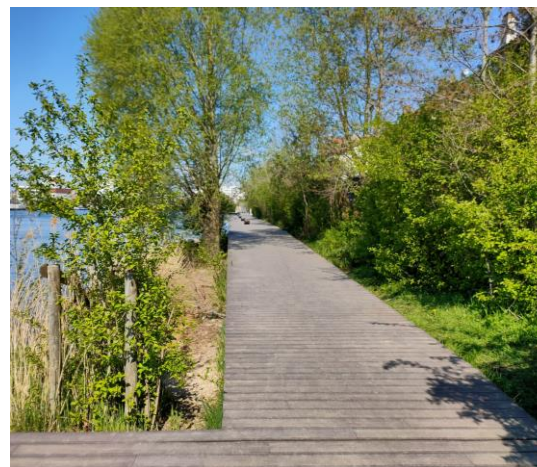
Aménagement platelage en bois – Choisy-le-Roi
