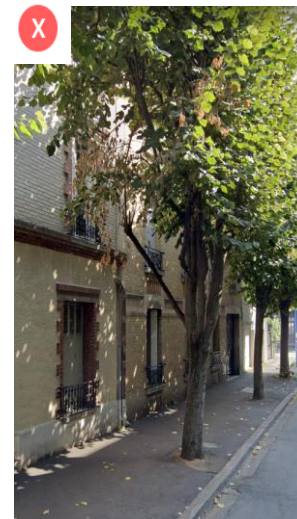
Pied d'arbre bétonné
