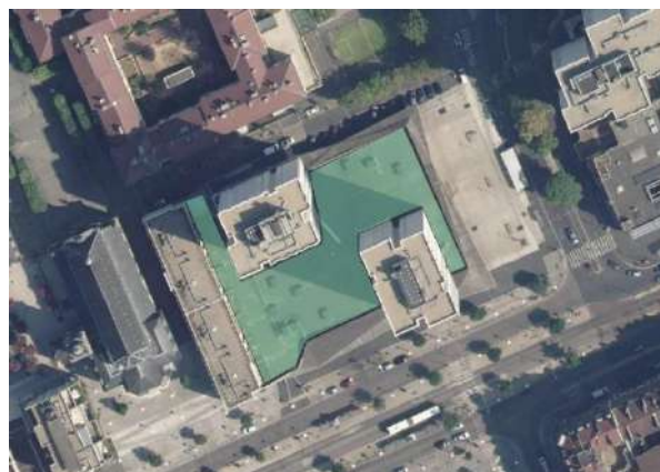
La toiture du marché du soir, présentant un large potentiel de végétalisation, Esplanade Jean Jaurès, Choisy-le-Roi
