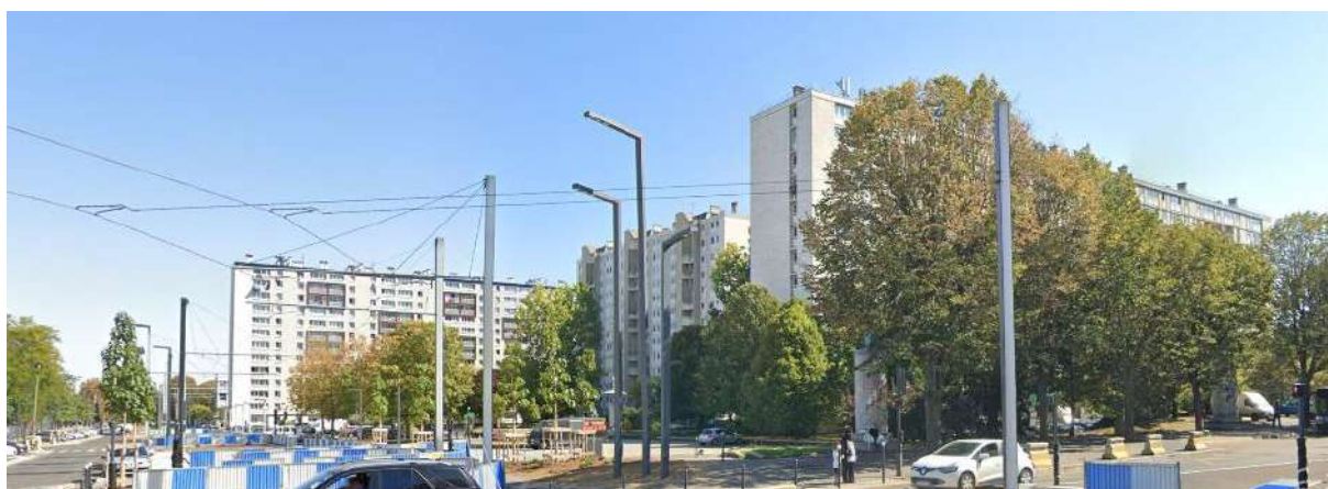
Exemples de ruptures d'échelles et de la diversité des formes bâties présentes tout au long de la RD
