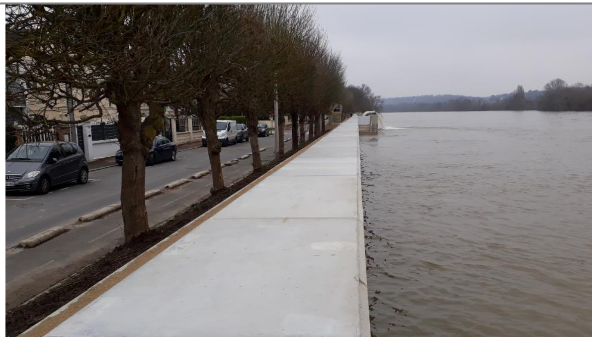
Photographie de la digue en février 2021 (pic de la crue) – copyright SMSO
