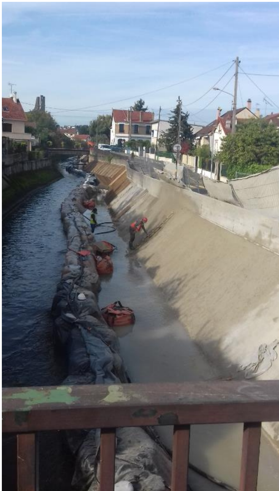
Chantier Morte-Rivière – Viry-Châtillon – Syndicat de l'Orge
