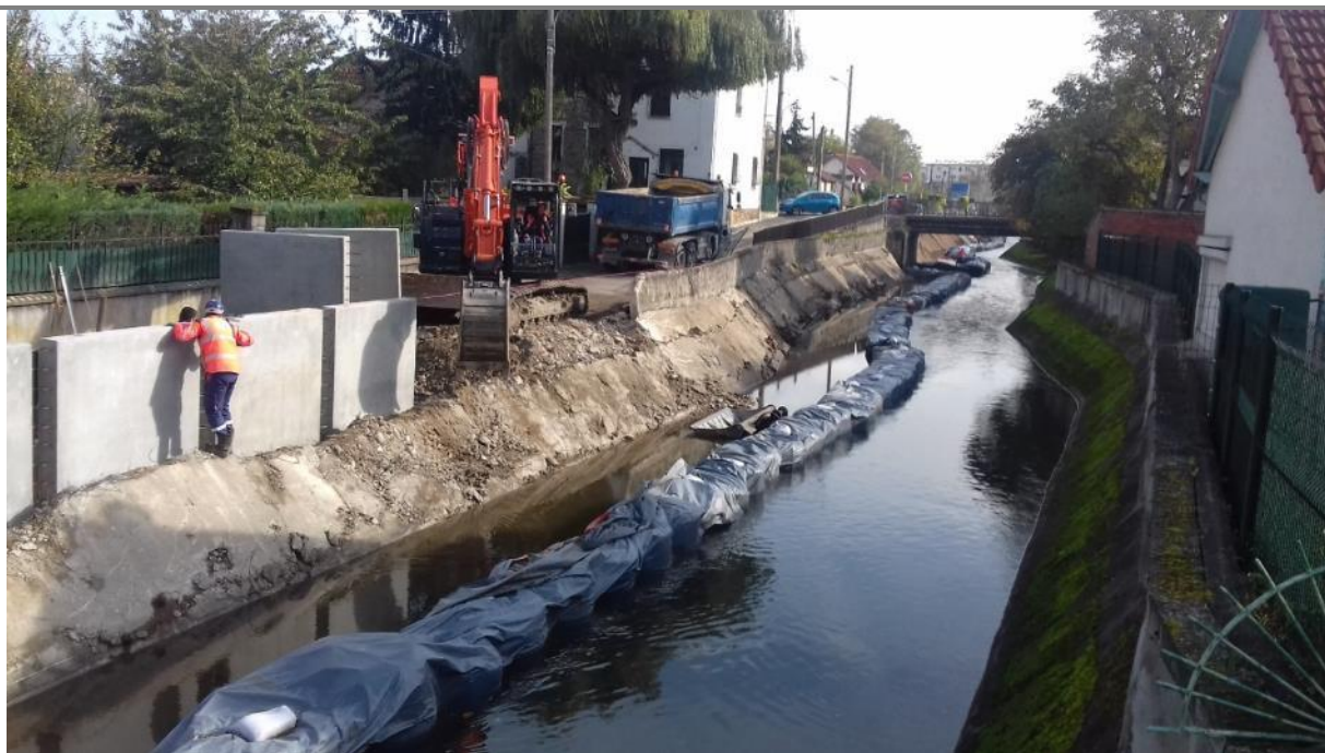
Reprise du parapet béton – Viry-Châtillon - Syndicat de l'Orge
