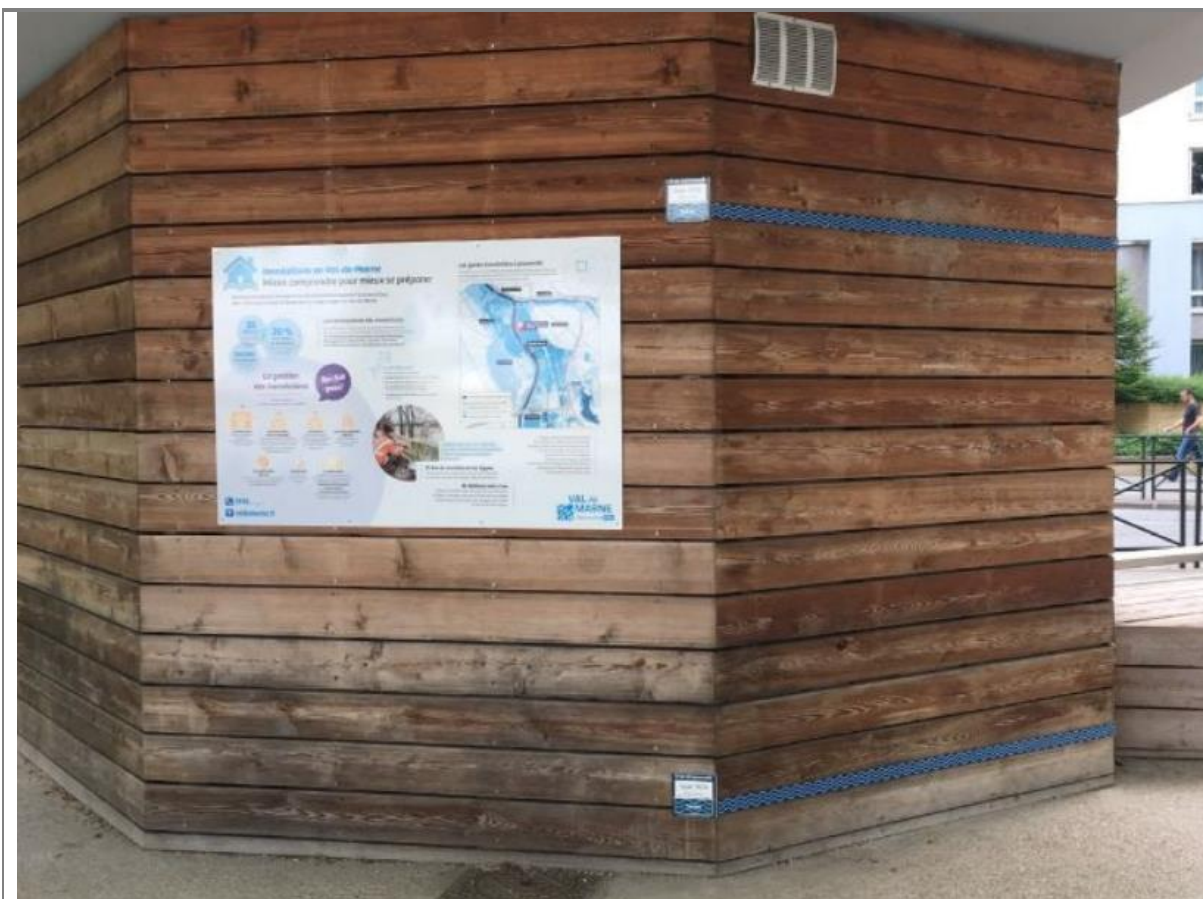
Repères de crue posés sur la station d'assainissement départemental « 14 juillet » à Alfortville (crédits CD94)
