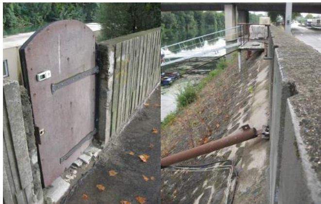
Exemples d'amarre sur murette et de portillon dans une ouverture © CD92-Direction de l'eau-2013
