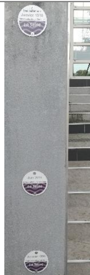
Bâtiment de la DEEA
