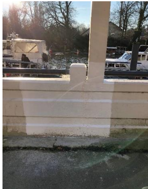
Réhabilitation de la murette anti-crue - Quai du Port à Nogent-sur-Marne (94) [2019] Copyright : CD94
