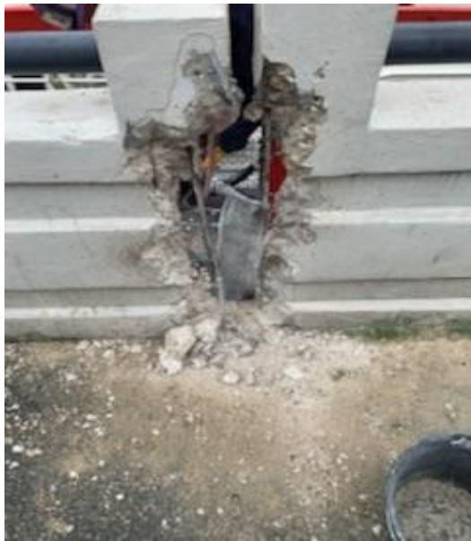
Réhabilitation de la murette anti-crue - Quai du Port à Nogent-sur-Marne (94) [2019] Copyright : CD94
