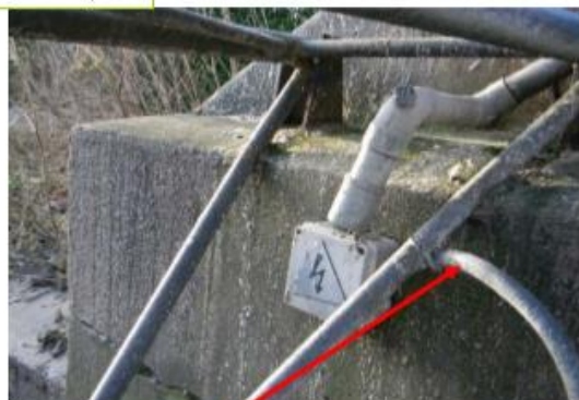
Passage du câble de la chambre au local technique
