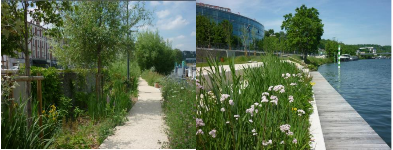
Bas-Meudon 2018-A gauche, murs anti-crue habillés de gabions et recouverts de végétation
