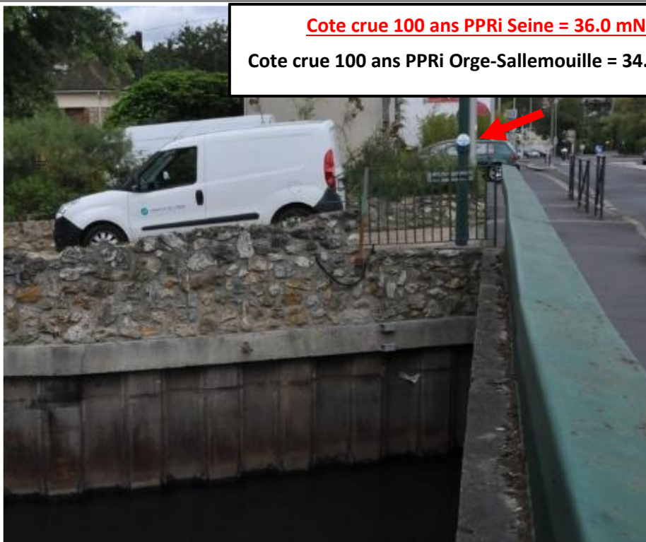
Repère de crue – Athis-Mons : Syndicat de l'Orge
