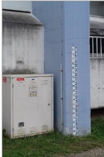
Exemples de règles limnimétriques installées (SyAGE)
