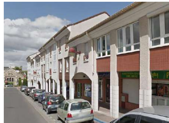
Arcades du Centre-ville de Fresnes
