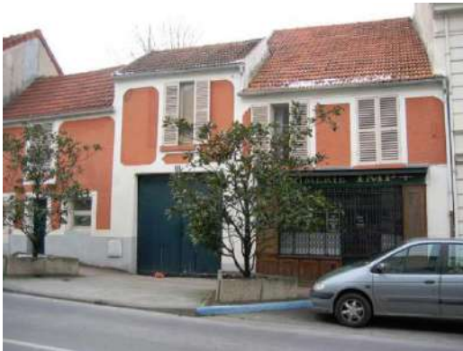
Façade principale de la maison
