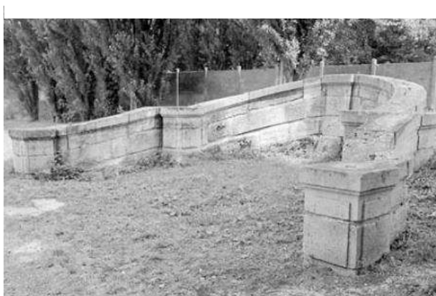
La tête du canal, en pierre de taille, un vestige du canal du Château de Tourvoie
