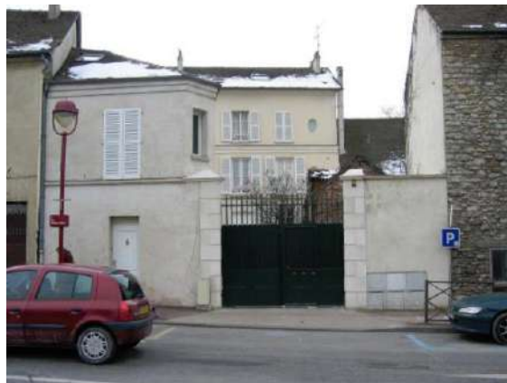
Façade principale de la maison
