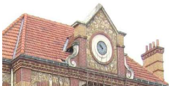
Détail de l'horloge de la mairie
