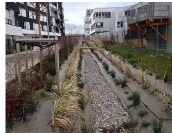
Nouvelles végétalisées, en pieds d'immeubles Ecoquartier de la Cerisaie
