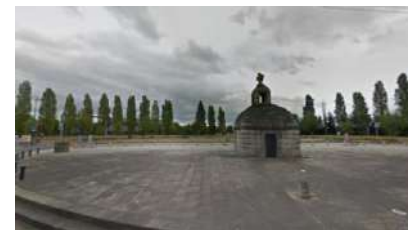
Ajout des alignements qui vient souligner le regard de l'Aqueduc de la Vanne.
