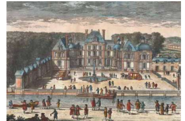
Façade du Château de Berny
