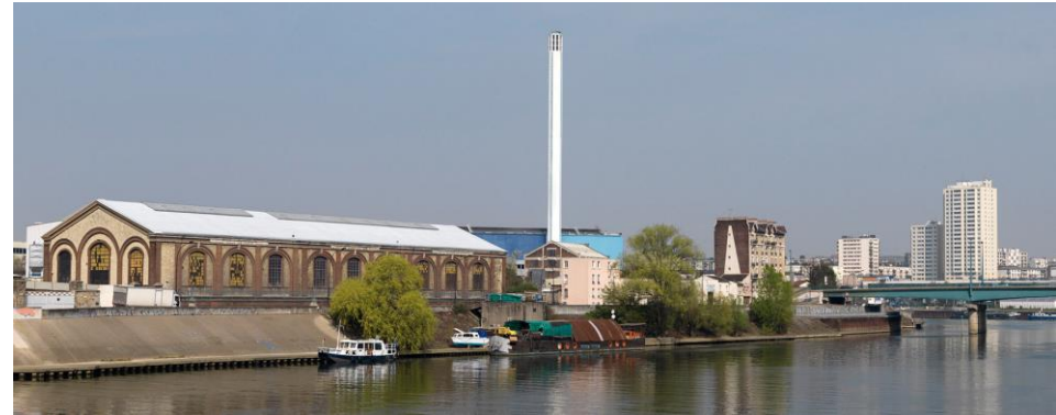
Vue sur l'usine des Eaux d'Ivry-sur-Seine – Source : Région Île-de-France
