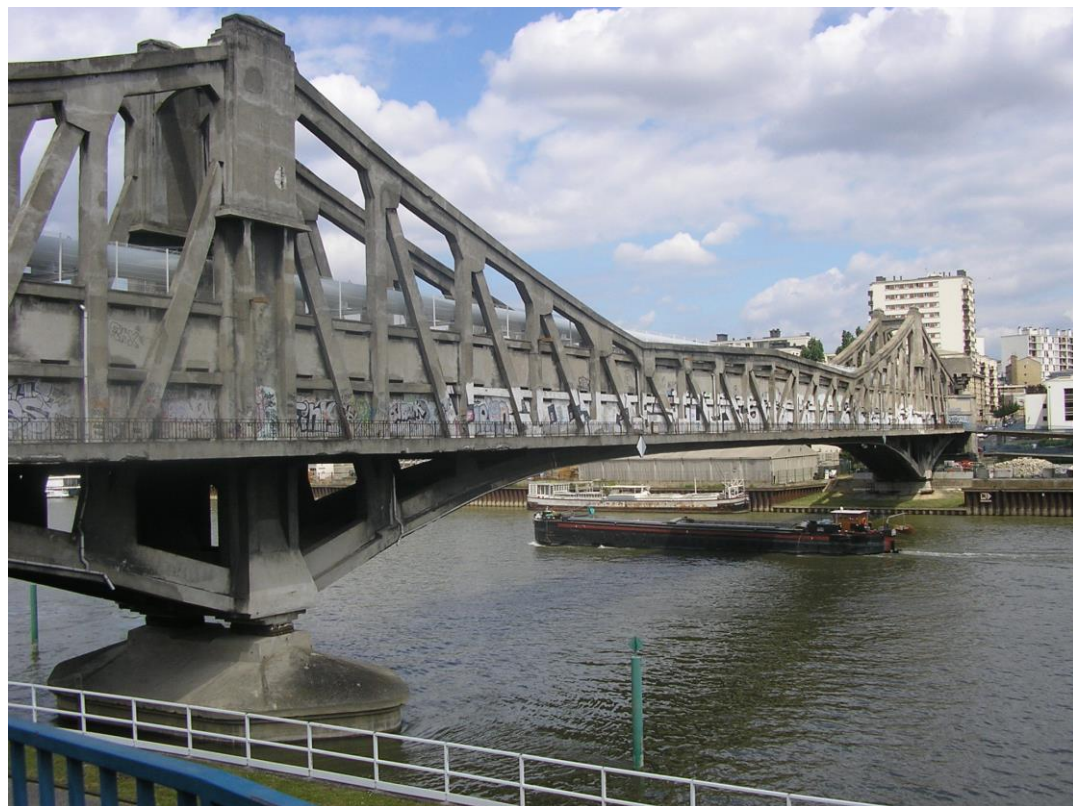
Vue de la passerelle industrielle d'Ivry-Charenton, dite également « passerelle aux câbles »
