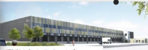
STEF (Q1c) - Construction d'un entrepôt - Livraison
