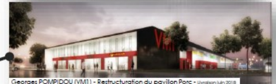
Georges POMPIDOU (VM1) - Restructuration du pavillon Parc - Livraison juin 2018
