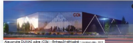
Alexandre DUMAS père (C0k) - Entrepôt réfrigéré - Livraison déc. 2019
