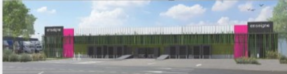
Jean GIOINO (F0c) - Construction d'un entrepôt réfrigéré - Livraison fév. 2018
