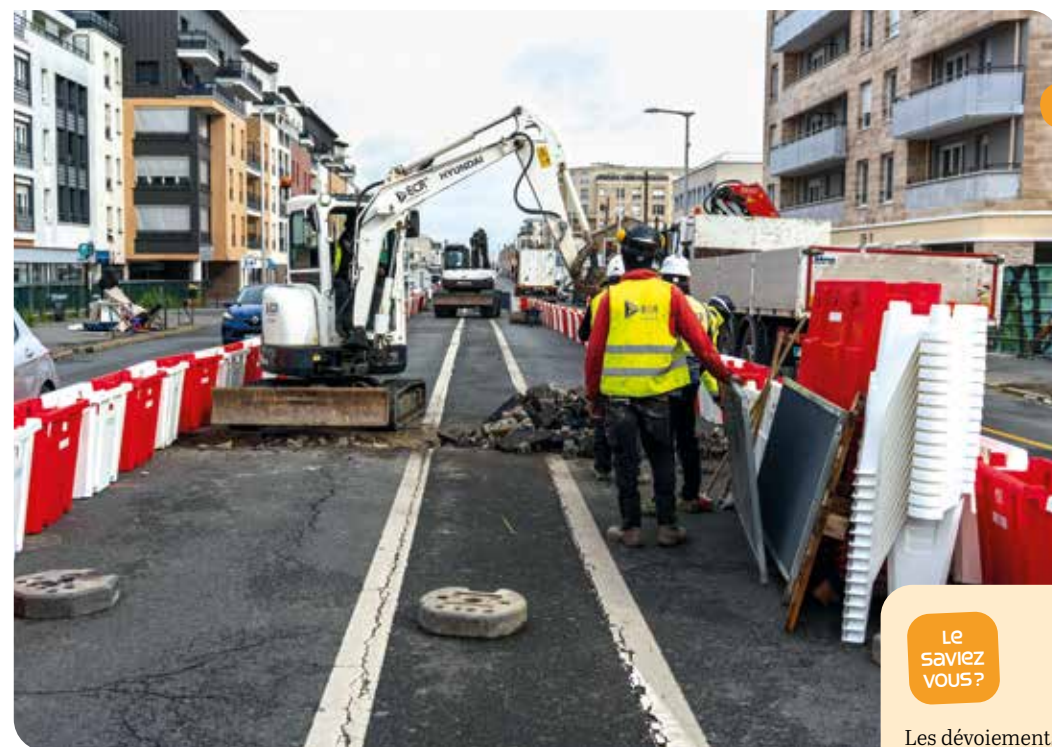
Travaux de préparation du prolongement du tramway 7 entre Athis-Mons et Juvisy-sur-Orge
