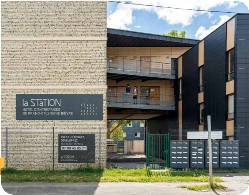
L'hôtel d'entreprises la Station, Viry-Châtillon
