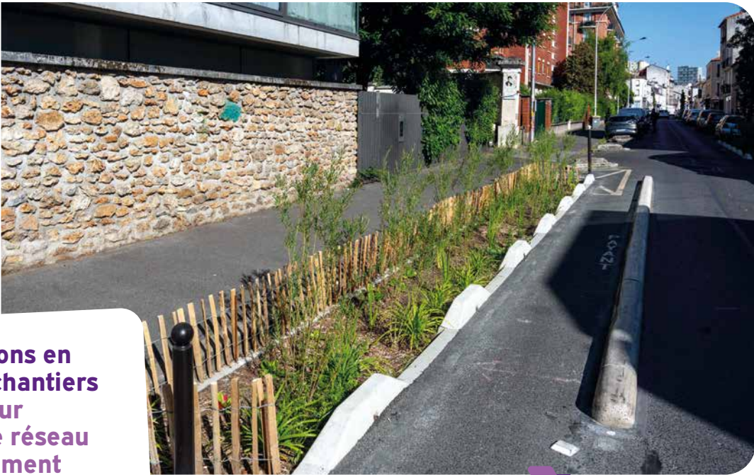
Noue d'infiltration des eaux pluviales, Ivry-sur-Seine
