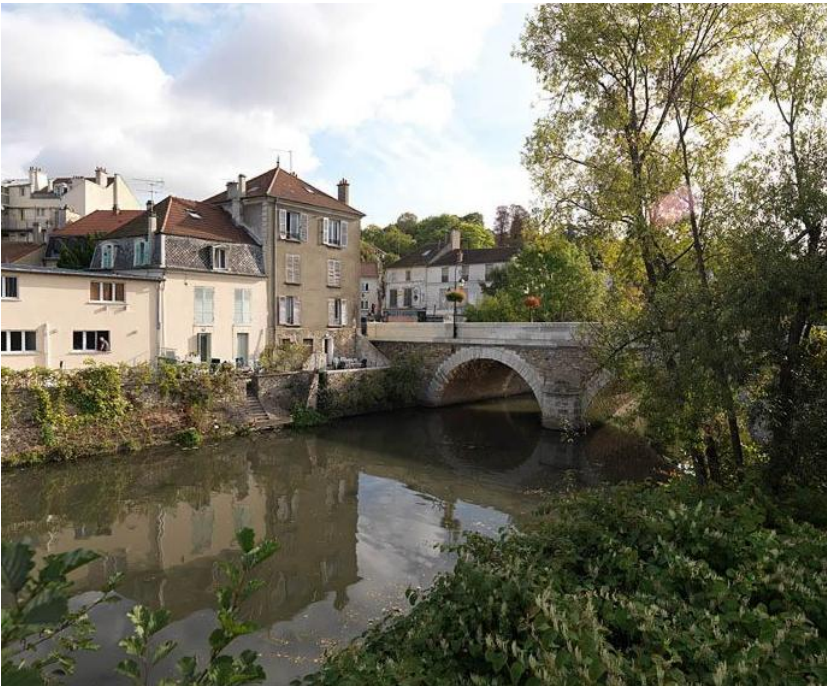
Pont sur l’Yerres à Villeneuve-Saint-Georges (Source : inventaire.iledefrance.fr)
